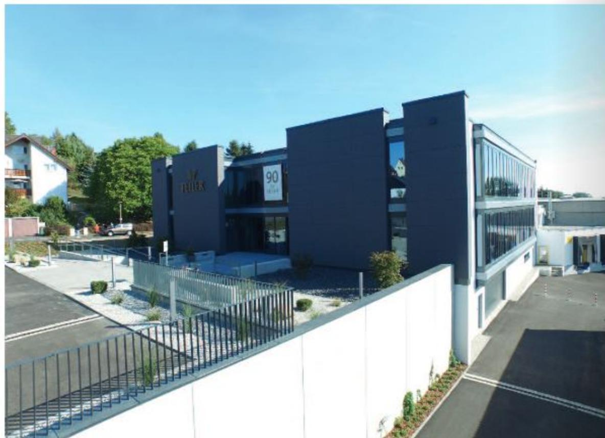
einen außenliegenden Sonnenschutz verzichtet. Stattdessen sind 1.000 m<sup>2</sup> Verglasung mit elektrisch schaltbaren Funktionsgläsern ausgerüstet, die die Aufgaben des Sonnenschutzes übernehmen und für Blendfreiheit im gesamten Verwaltungsgebäude sorgen. Grelles Licht und Hitze bleiben dadurch draußen. Diese
